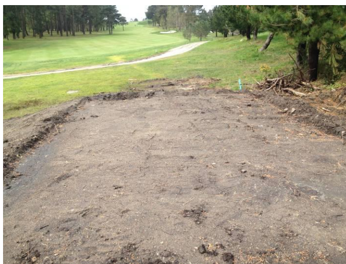
Foto 10. Inicio trabajos nueva plataforma tees hoyo 2.
