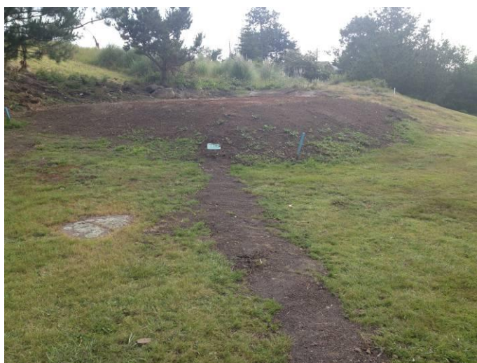
Foto 8. Plataforma nueva en el tee del hoyo 2 y zanjas del sistema de riego.
