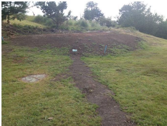
Foto 8. Plataforma nueva en el tee del hoyo 2 y zanjas del sistema de riego.
