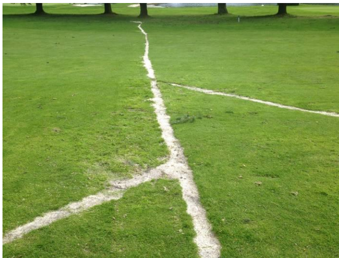
Foto 8. Drenajes en la calle del hoyo 13.
