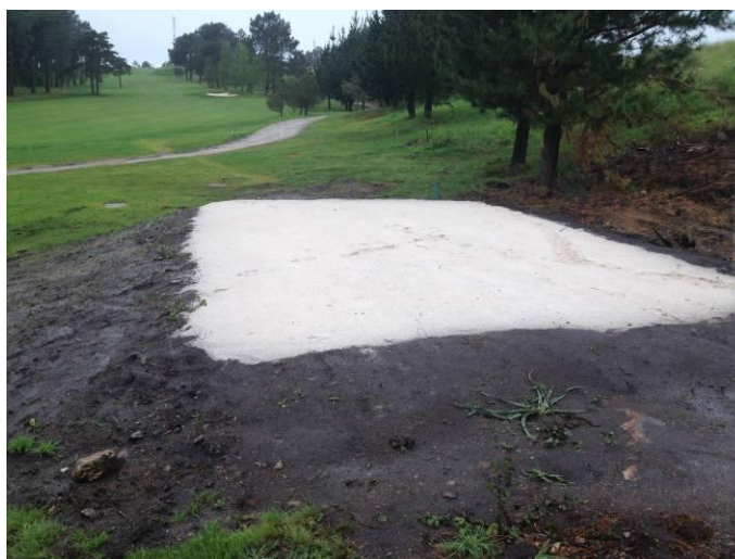
Foto 7. Estado actual de la plataforma nueva en el tee del hoyo 2.
