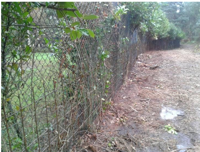
Foto 15. Malla de seguridad en el perímetro del campo.
