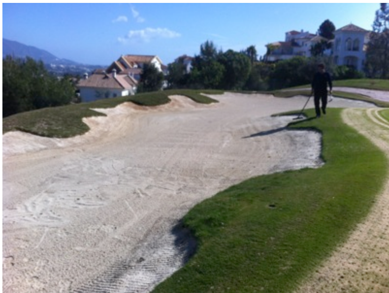
Foto 11: Aspecto general que presentan los bunkers
