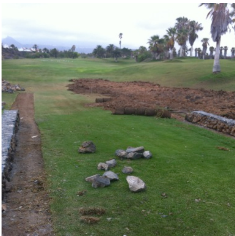
Foto 11: Obras de renovación en los tees del hoyo 4 del recorrido Links.
