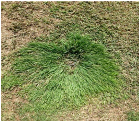
Fotos 1 y 2: Aspersores hundidos o enterrados observados en el campo.
