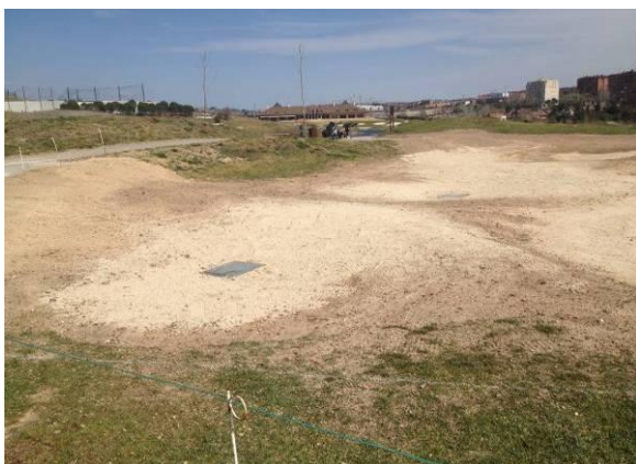
Foto 17. Obras en el hoyo 15.
