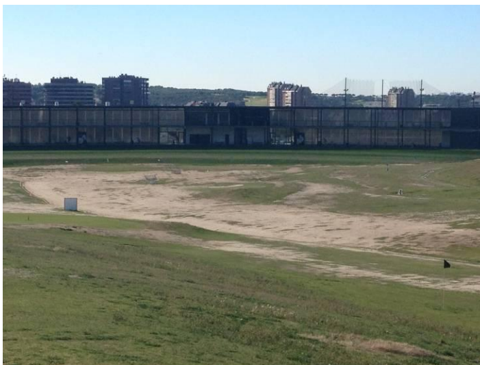
Foto 23. Estado actual de la cancha de prácticas.
