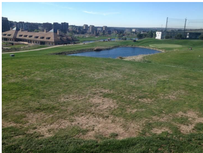
Foto 10. Estado actual de la plataforma del hoyo 9.
