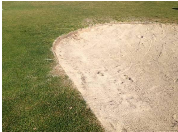
Foto 16. Misma zona tras la reparación.
