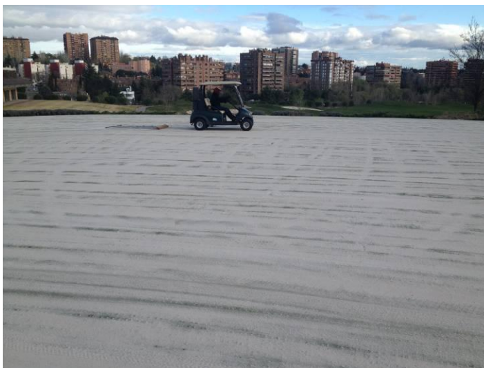
Foto 6. Paso de rastra.
