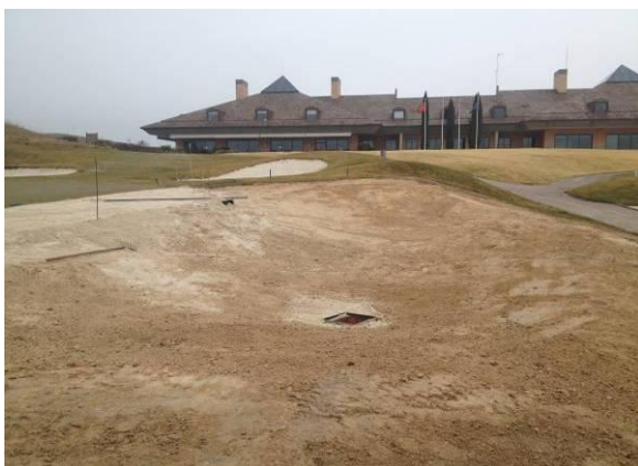
Foto 19. Obra en el hoyo 18.
