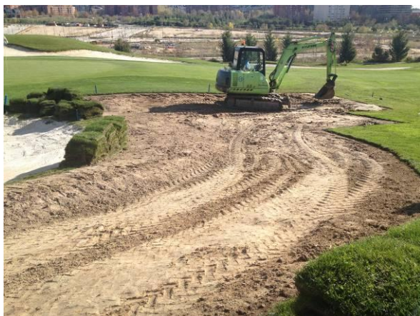
Foto 12. Bunker de green del hoyo 1.
