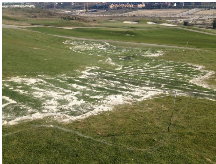
Foto 9. Obra de drenaje en la calle del hoyo 5.
