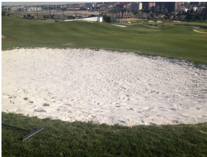
Foto 16. Estado actual del bunker del hoyo 12 con drenaje mediante Drenotube.
