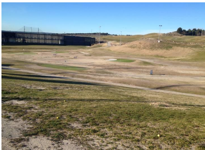
Foto 20. Estado actual de la cancha de prácticas.
