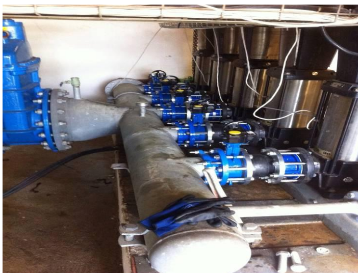
Foto 19. Obra realizada en el sistema de bombeo de calles.
