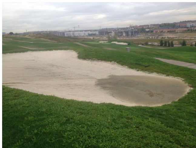
Imagen 11. Estado general bunker tras las lluvias.
