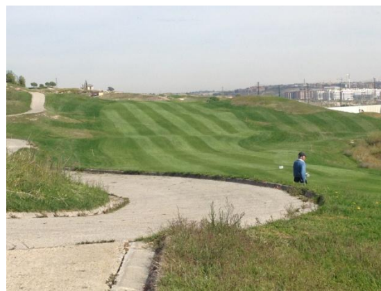
Imagen 7. Estado general de la calle del hoyo 12.
