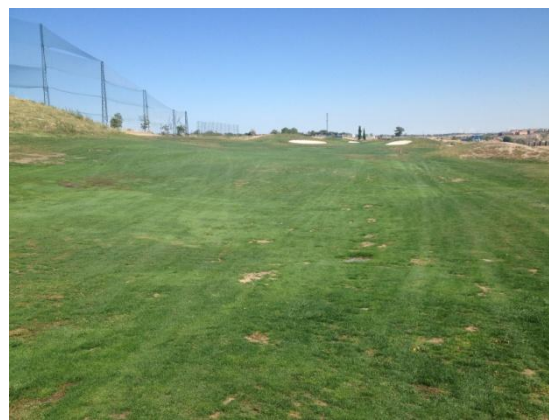
Imagen 4. Estado general de una calle.
