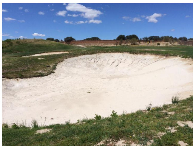
Imagen 11. Estado general bunker.
