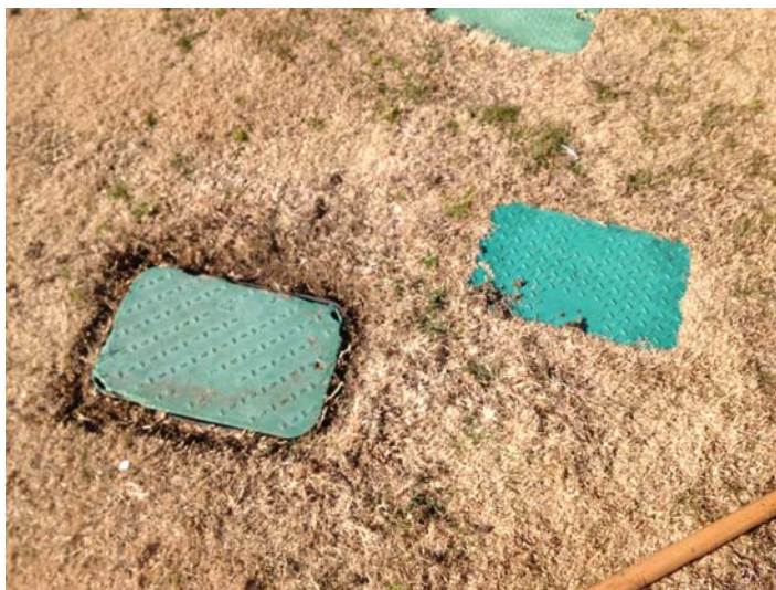
Imagen 3. Comparativa entre arqueta limpiada frente a otra sin limpiar
