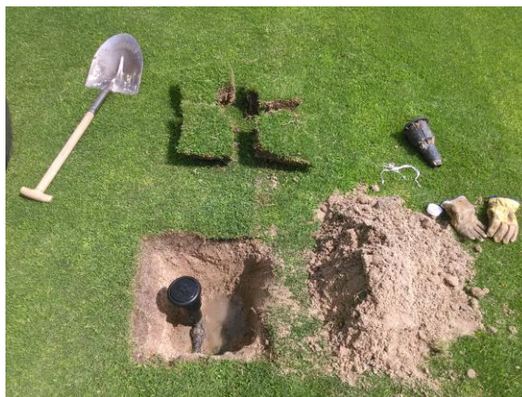
Foto 6: Momento de la reparación
