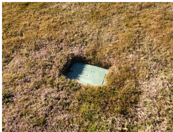
Foto 2: Estado general de las arquetas de riego.
