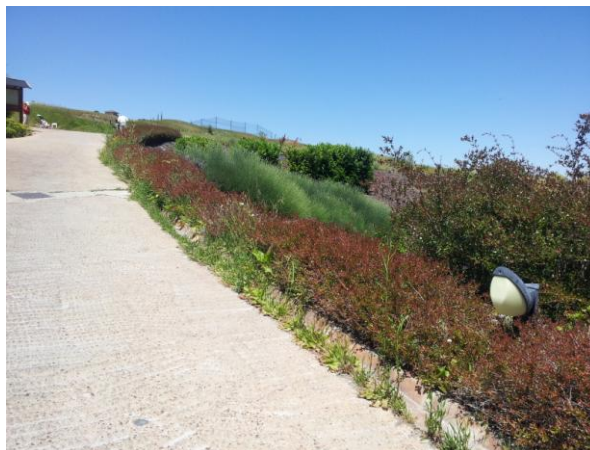
Foto 7: Parterres con malas hierbas en la zona de subida al putting.
