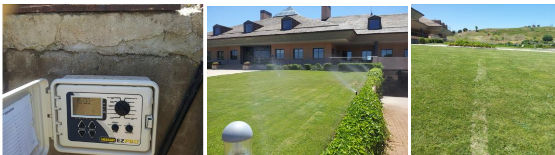
Foto 1, 2 y 3: Programador de riego, solapes de aspersores y nivelación de zanjas.
