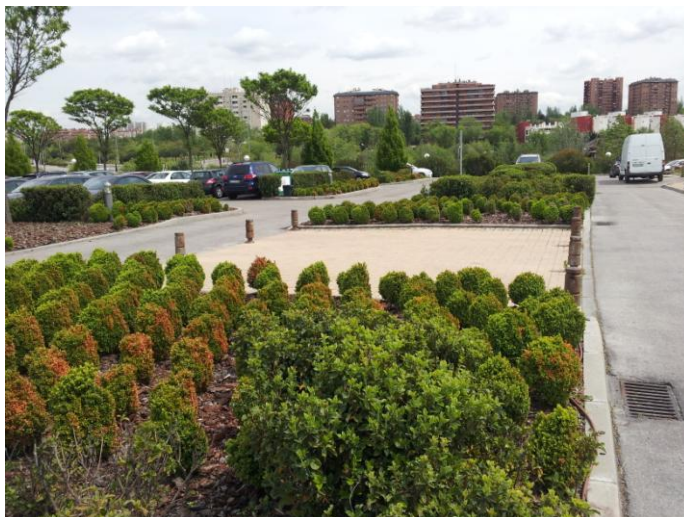
Imagen 2: Estado general de la entrada.
