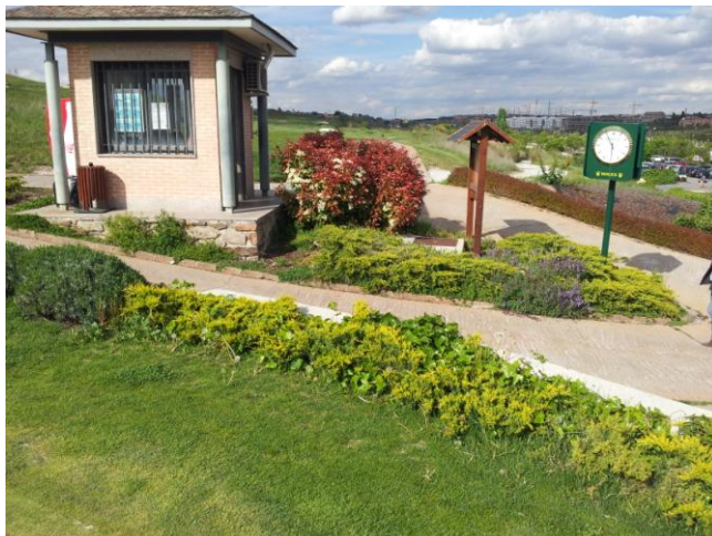
Imagen 7: Estado general del putting.
