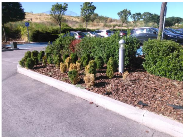
Foto 4: Arriate en el que se observan arbustos secos, tela anti malas hierbas y tuberías de goteo descubiertas.
