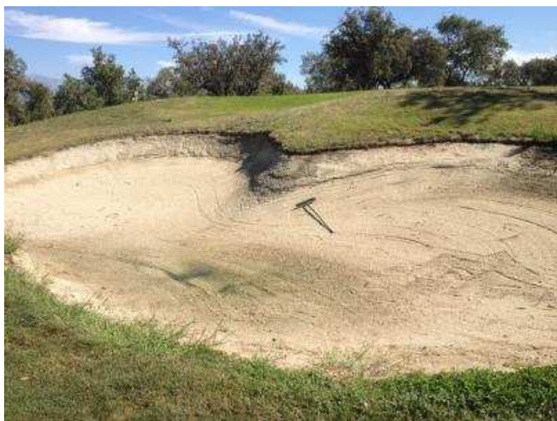
Imagen 23. Estado general bunker
