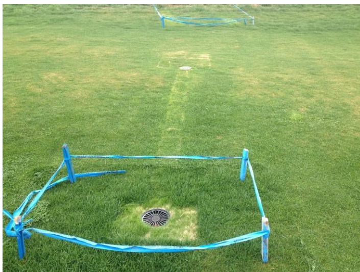
Foto 12. Zona del hoyo 9 con mejoras en el drenaje.
