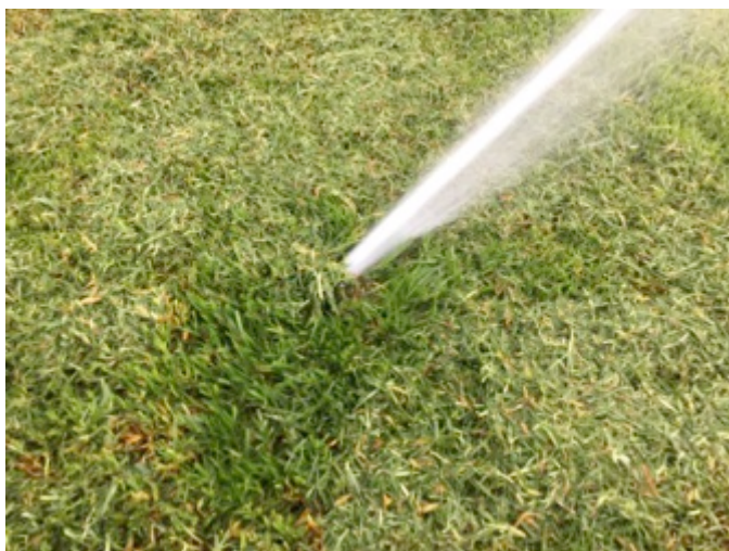
Foto 1: Aspersor completamente enterrado con el chorro golpeando el suelo.
