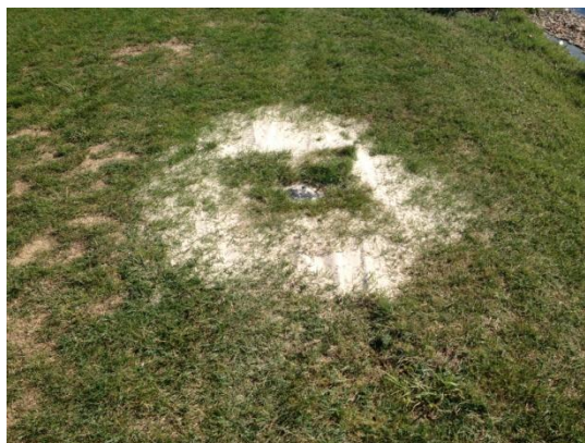
Foto 14. Reparación de un aspersor próximo a los tees del hoyo 10.
