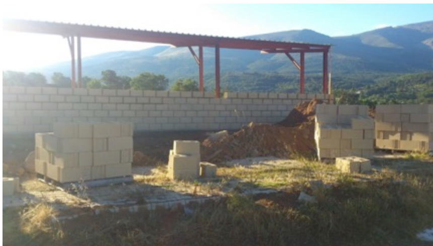
Cerramiento con 4 ventanas.
