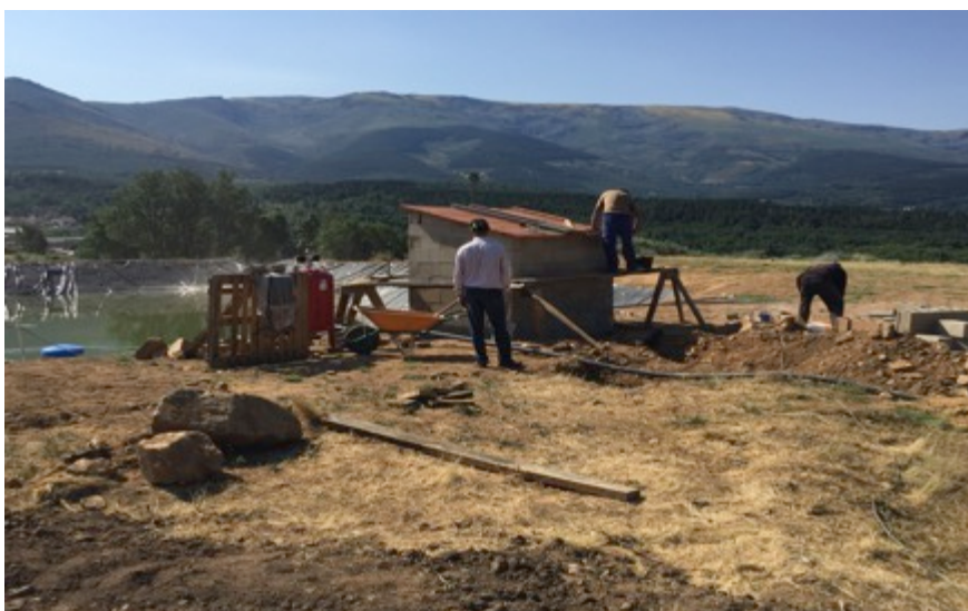
Bombeo ya instalado dentro y sólo falta finalizar la colocación de tejas y enlucirlo.
