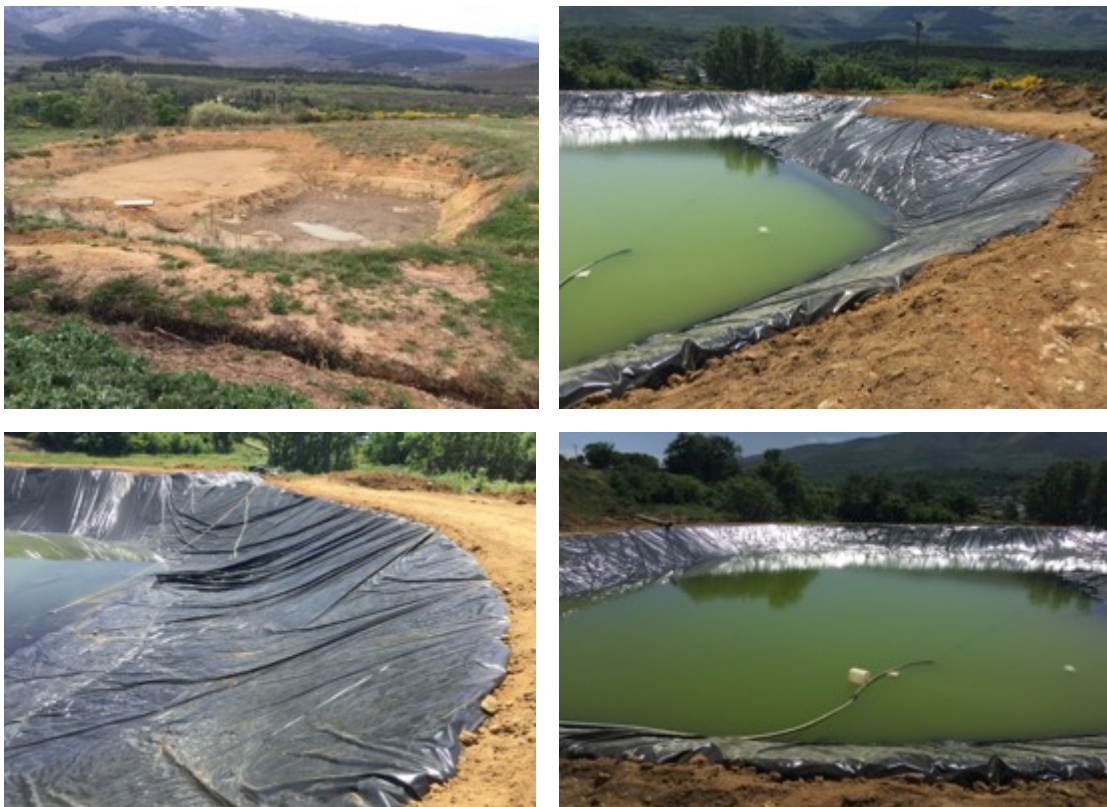
Evolución del moldeo y la impermeabilización de la balsa de riego.
