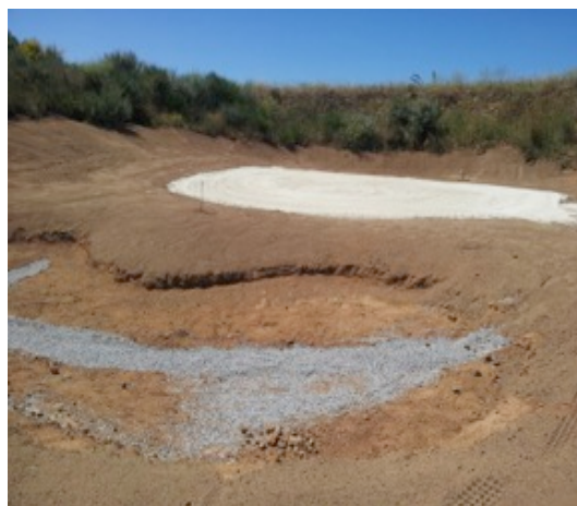
Sistema de drenaje y capa de grava
