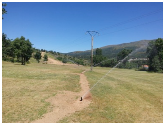
Calle #2 regando una vez instalados los aspersores.
