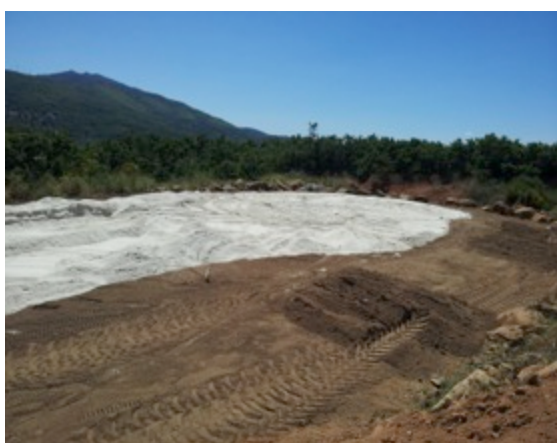
Capa enraizamiento -Vertido de arena
