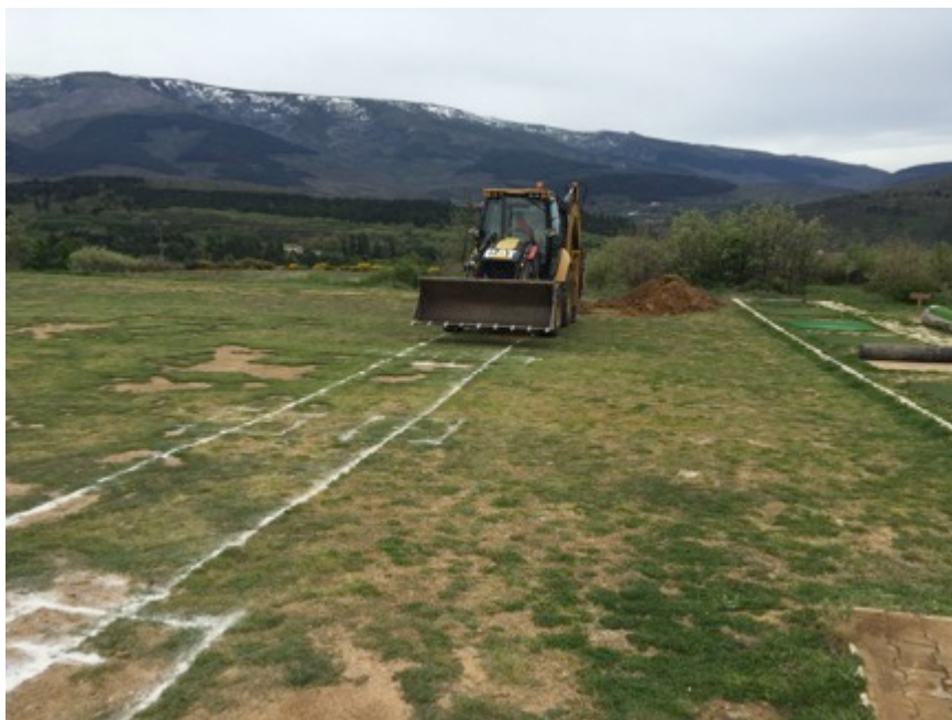
Inicio de la excavación. 24 abril 2015.
