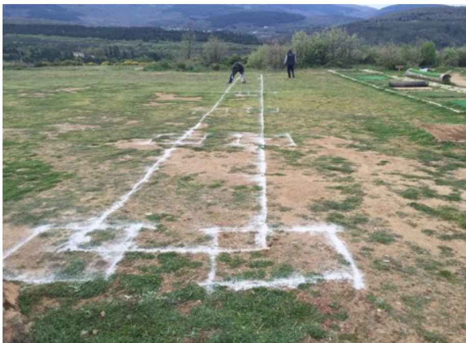
Replanteo de las zapatas y correas de la nueva marquesina en la cancha de prácticas.
