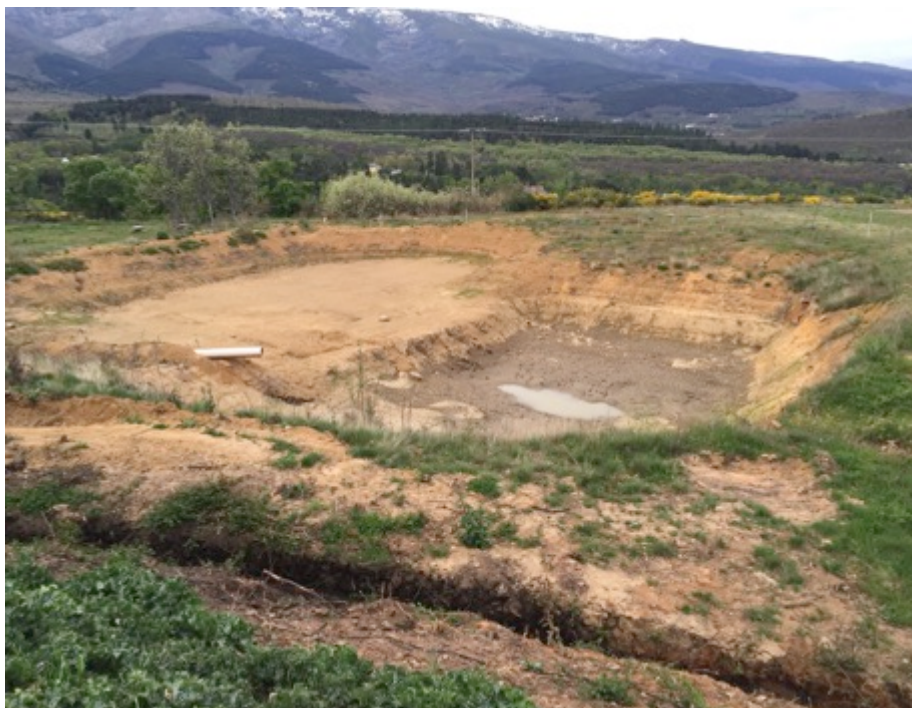
Balsa de riego vacía preparada para el moldeo y la impermeabilización.
