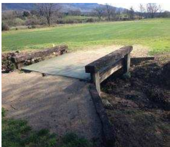
Puente de calle 8
