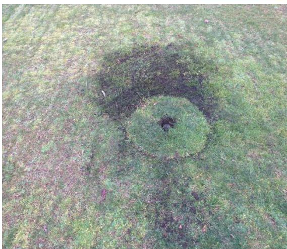
Nivelación de aspersores
