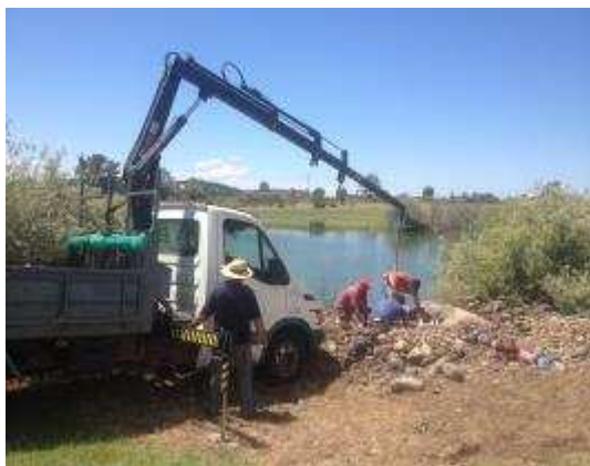
Extracción de la bomba
