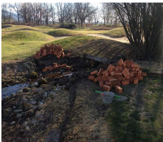
Puente 7 en construcción
