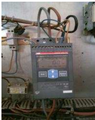
Arrancador de la bomba sustituido
