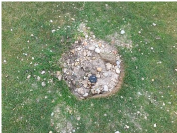
Foto 11: Aspersor nivelado con el terreno original lleno de piedras.
