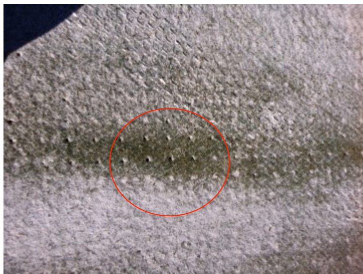
Foto 6: Huecos con falta de arena en su interior.
