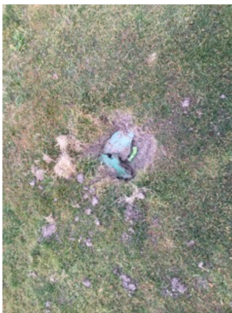
Foto 4: Hidrante enterrado con la tapa partida.
