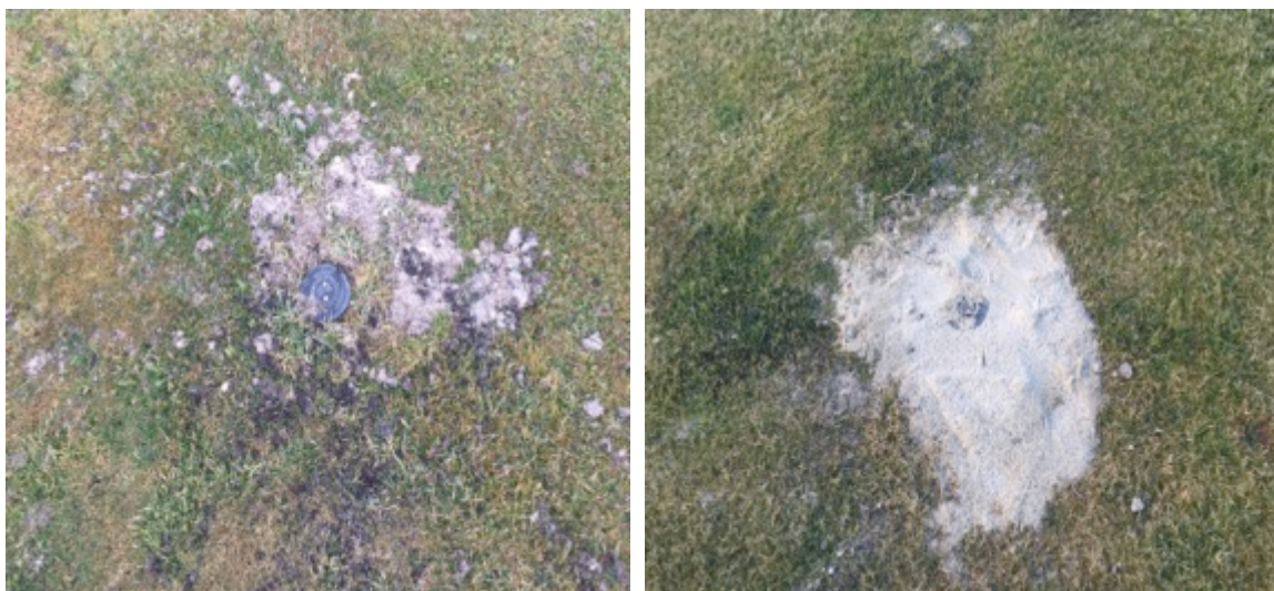
Fotos 2 y 3: Diferencia entre un aspersor nivelado y repuesto con tierra original (izqda.) y uno con arena limpia (drcha.)
