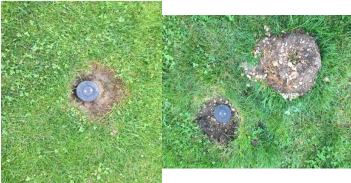
Imágenes 16 y 17. Aspersores con el cerco abierto tras su limpieza.
