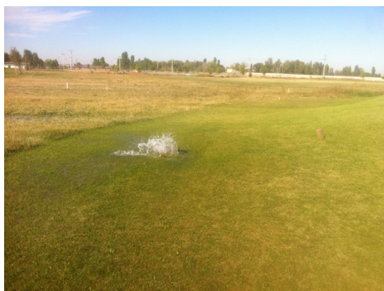
Imágenes 12, 13 y 14. Fuga en aspersores, falta de nivelación y pérdidas en electroválvulas.
