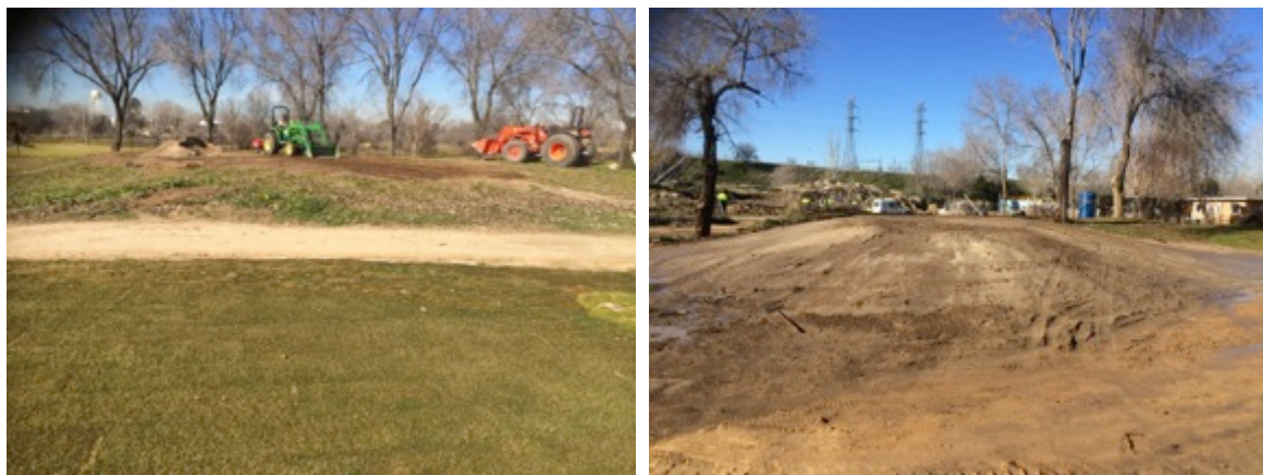
Foto 4: Proceso de construcción de nuevas plataformas de tee. En la foto, plataforma de amarillas del hoyo 9 (Izq) y plataforma de rojas del hoyo 2 (Dcha).
