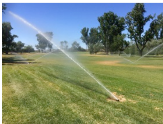
Foto 7: Detalle del replanteamiento de 3 aspersores en la calle 4. Nótese en la foto de la izquierda el patrón de la seca por falta de cobertura.
