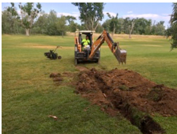
Foto 7: Detalle del replanteamiento de 3 aspersores en la calle 4. Nótese en la foto de la izquierda el patrón de la seca por falta de cobertura.
