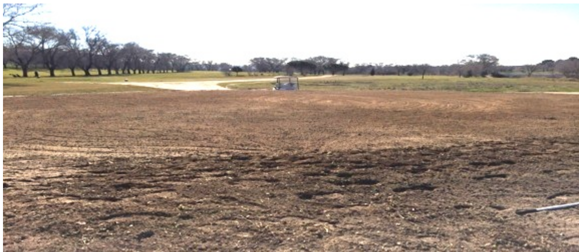
Foto 6: Detalle de la nueva plataforma de amarillas del tee del hoyo 9, una vez acabado el aporte de material y nivelado de la superficie.
