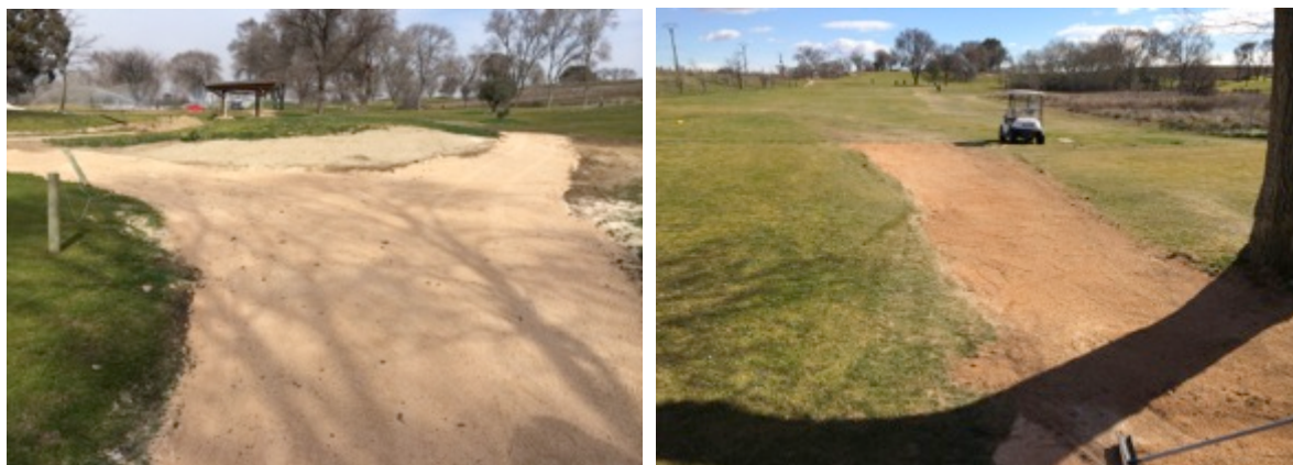
Foto 7: Detalle del proceso de reparación de caminos en las cercanías de varias plataformas de salida.
