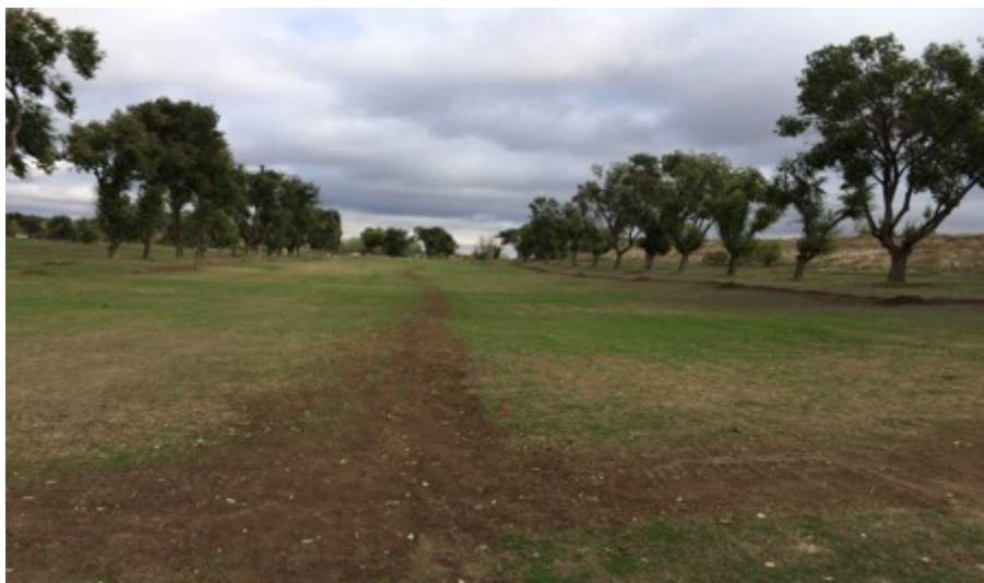
Foto 7: Detalle del progreso de la obra de renovación de riego de los hoyos 8 y 17. Nótese la lenta recuperación de estas calles, las cuales no han sido regadas en todo el verano.
