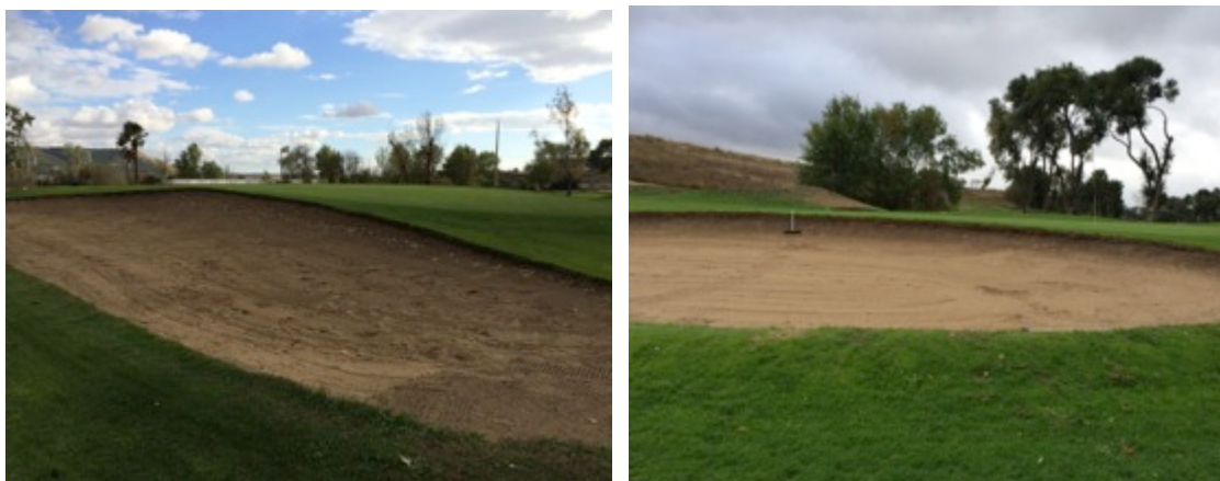
Foto 6: Detalle del estado general de los bunkers.
