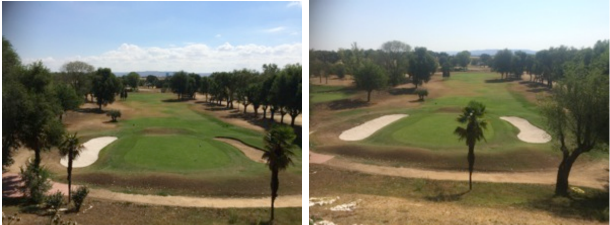
Foto 6: Detalle del proceso de retirada y relleno de los bunkers con arena silíceas.
