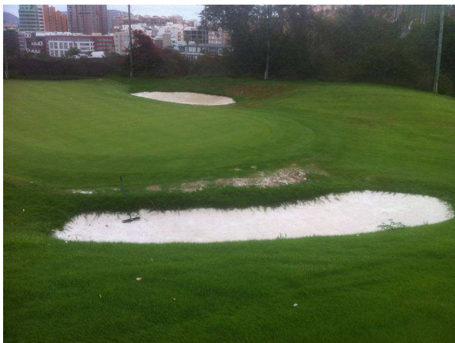
Foto 14. Talud de bunker sin cobertura.
