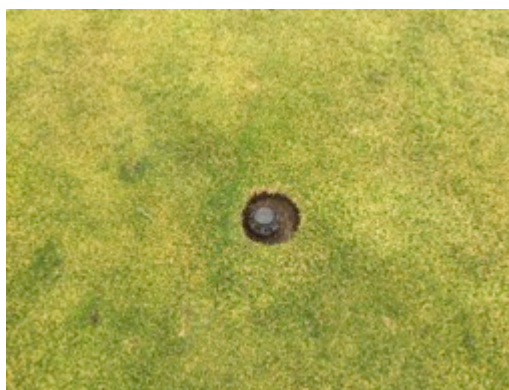
Fotos 16, 17 y 18: Detalle de las herramientas de limpieza creadas y su efecto sobre la limpieza de los aspersores.
