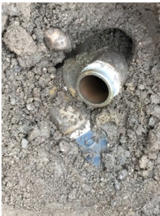
Foto 19: Aspersor con juego de codos rígido que impide una correcta nivelación.
