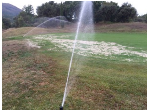
Imagen 11: Revision del funcionamiento y sectorización de muchos aspersores de green.
