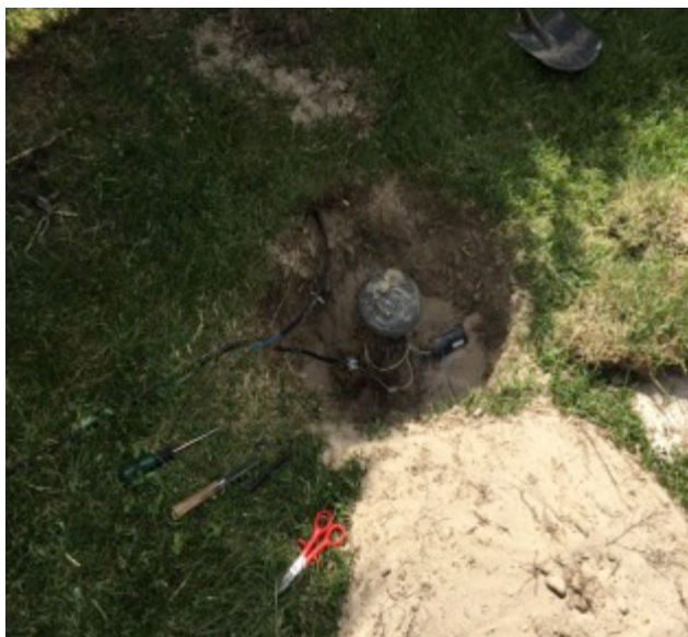
Imágenes 15-16. Instalación y conexión de un cable de señal nuevo en el circuito de riego de la zona alta.
