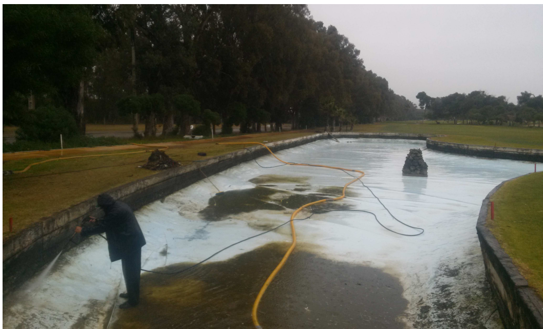
Limpieza lago de almacenaje de agua de riego
