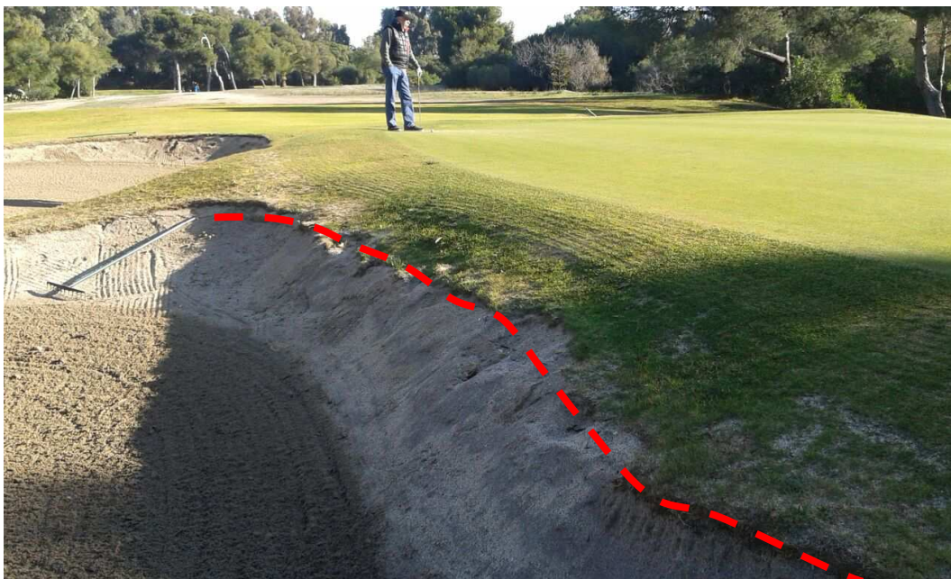
La línea muestra el lugar del muro de contención
