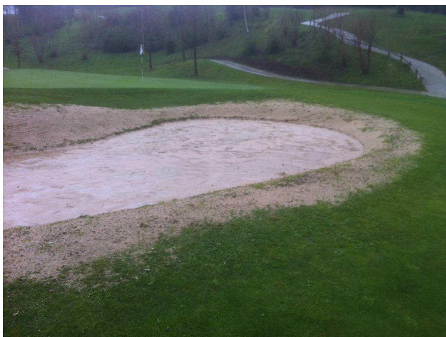
Foto 11. Acondicionado de los bunkers.
