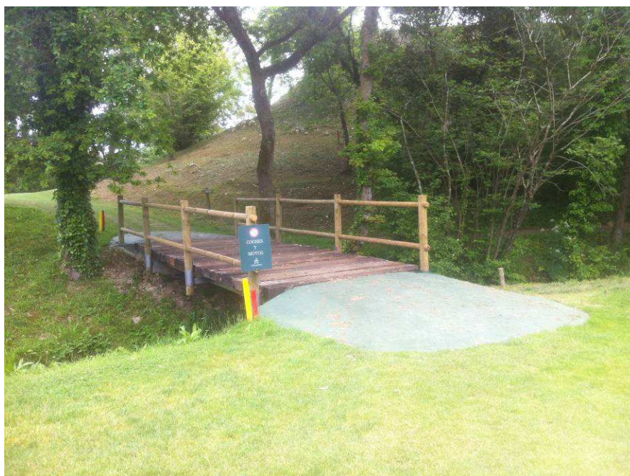
Foto 4. Reconstrucción de los puentes del recorrido.
