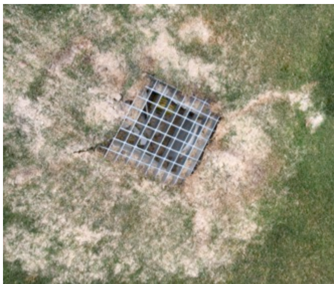
Foto 13: Nuevas arquetas de tramex colocadas.
